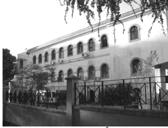
L'hôpital, côté magasins. État actuel (2007).
